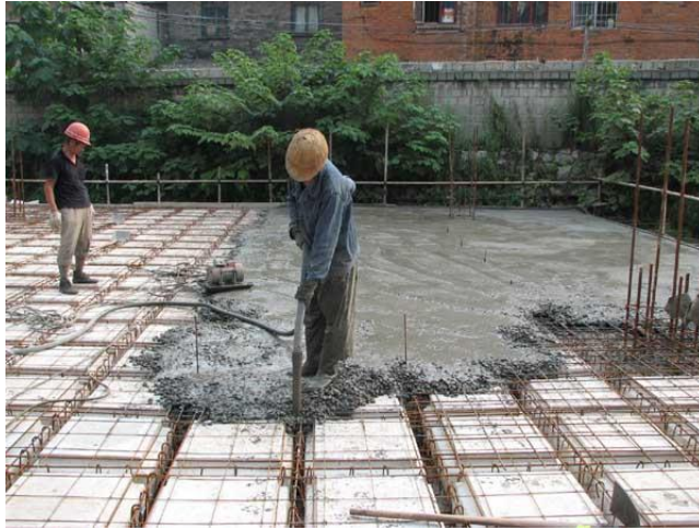
图2 石膏模盒施工现场
