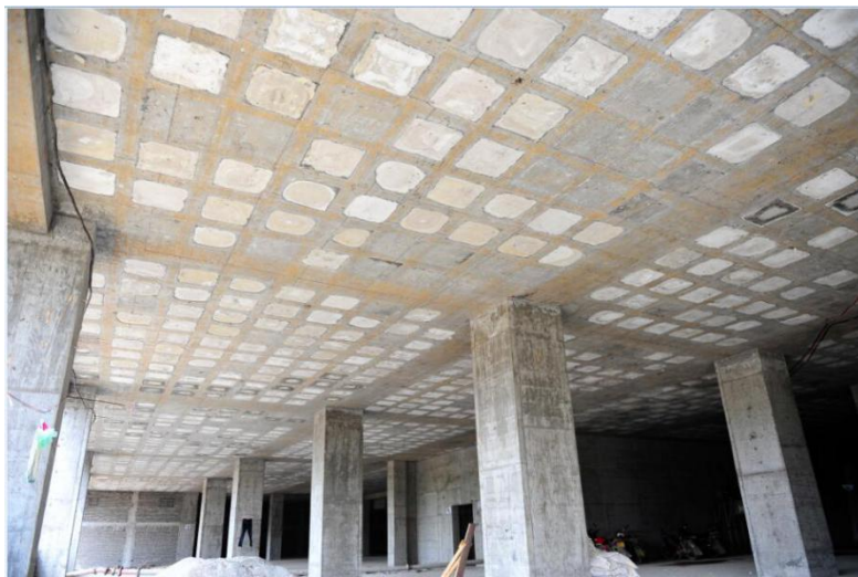
图3 石膏模盒施工应用
