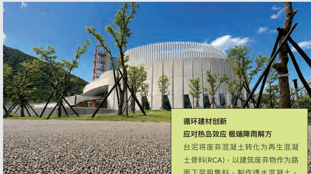
和平厂RRRC透水混凝土铺面
